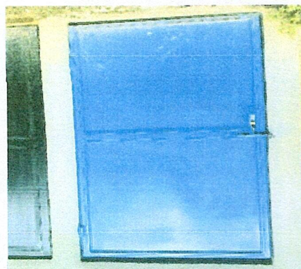
Foto 4: mejoramiento de puerta
