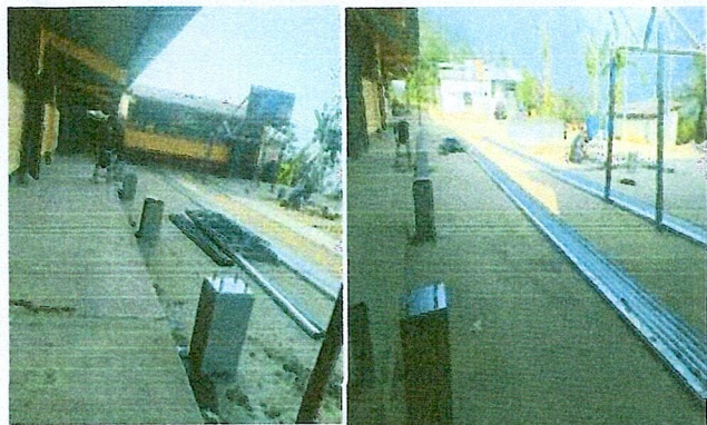
Foto 1: mejoramiento estructura metalico
